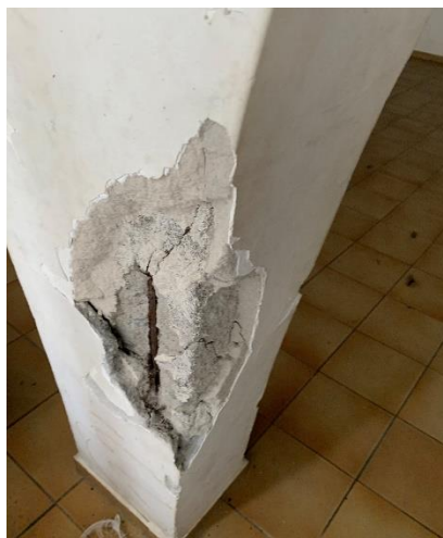
Reparo estrutural nos Pilares da área externa com secção e armadura comprometida
