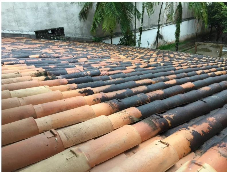
Revisão em telhado com troca de telhas cerâmicas do tipo colonial conforme as peças existentes, mantendo originalidade do mesmo
