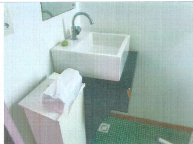
FIGURA 73 lavatório no banheiro que deveria ser acessível, porém não atende NBR 9050
