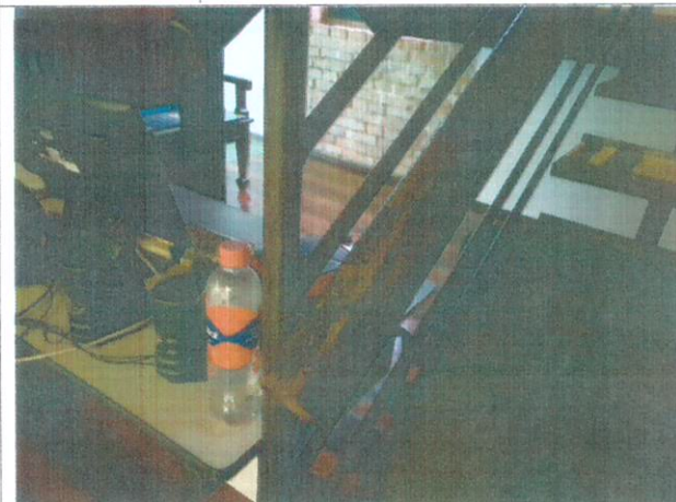
FIGURA 75 corrimão metálico da escada do mezanino com corrosão da pintura
