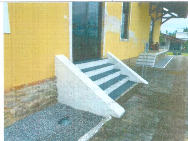
FIGURA 63 parede frontal esquerda da área de acesso em boas condições e direito com descascamento de tinta
