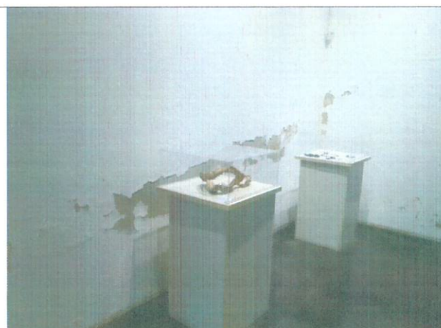
Figura 21: vista interna da parede da fachada do embarque e desembarque - descascamento da tinta - fissura
