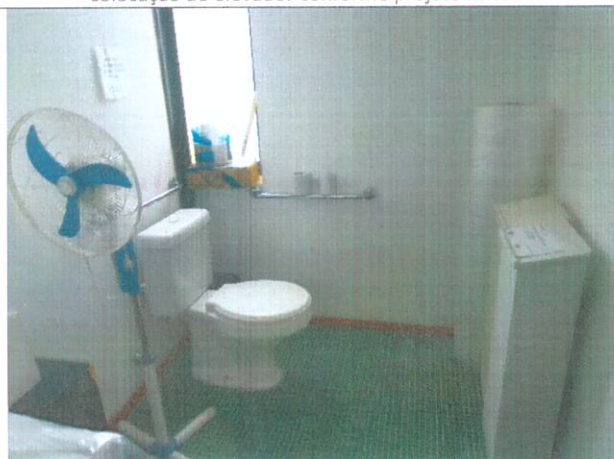
FIGURA 74 vista do lavabo adaptado PNE onde há obstáculos que impedem o giro 180° da cadeira de rodas
