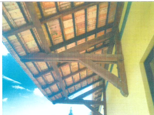
Figura 15: vista da fachada de acesso a estação – madeiras sem pintura de proteção
