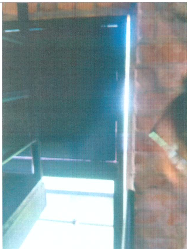
Figura 53: falta de vedação das esquadrias – pontos de ingresso de água, pontos de entrada/saída de ventilação
