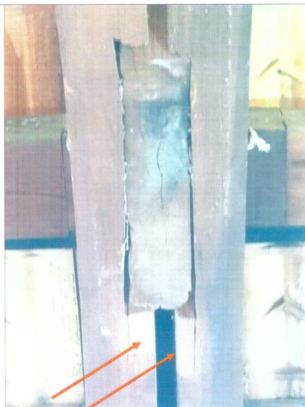
FIGURA 79 uso de peças para complementar o vão de encaixe
