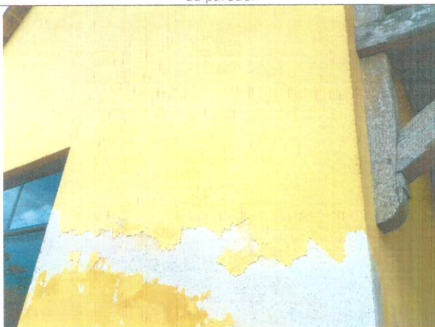
FIGURA 58 Descascamento da pintura decorrente de umidade na parte média da parede – lado esquerdo da área de embarque
