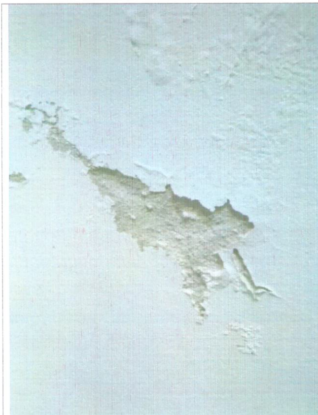
Figura 25: detalhe da parede da fachada do acesso - descascamento da tinta e desprendimento do reboco – fissura externa
