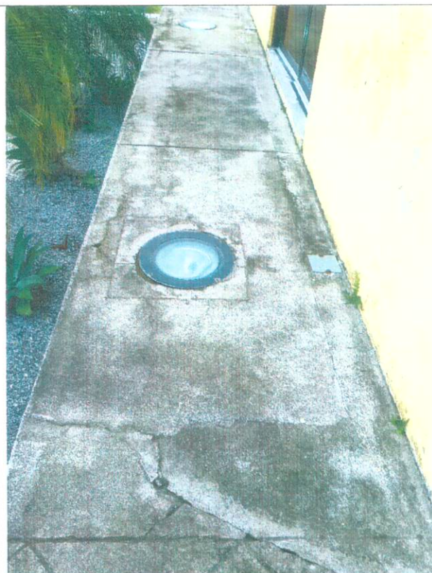
FIGURA 83 calçada com diversos locais de ingresso a acumulo de água na parede lado esquerdo da área de embarque
