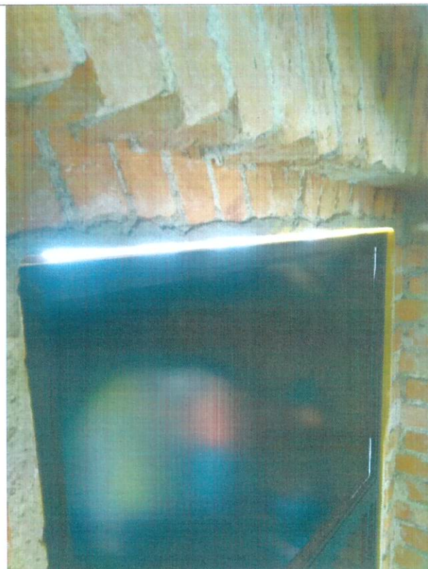
Figura 54: falta de vedação das esquadrias – pontos de ingresso de água, pontos de entrada/saída de ventilação
