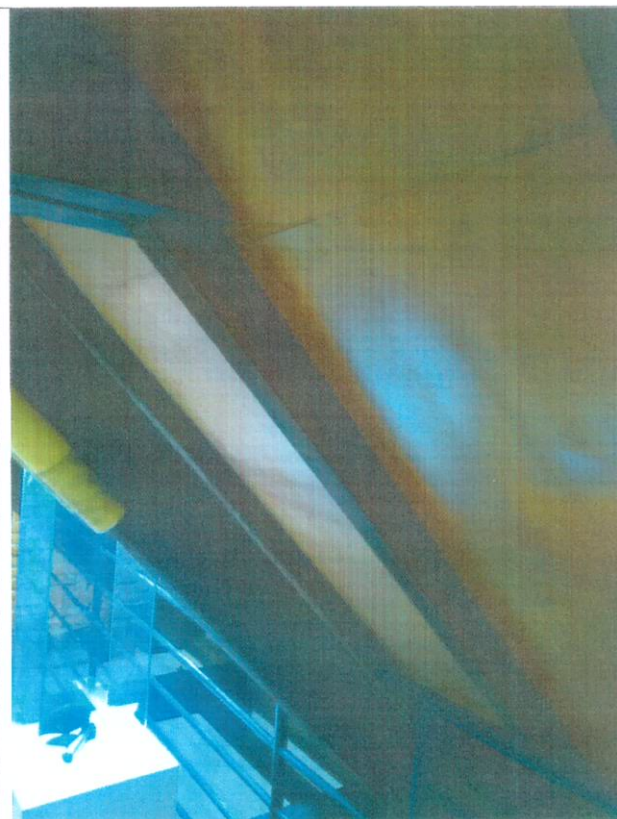
Figura 46: forro MDF danificado pela umidade
