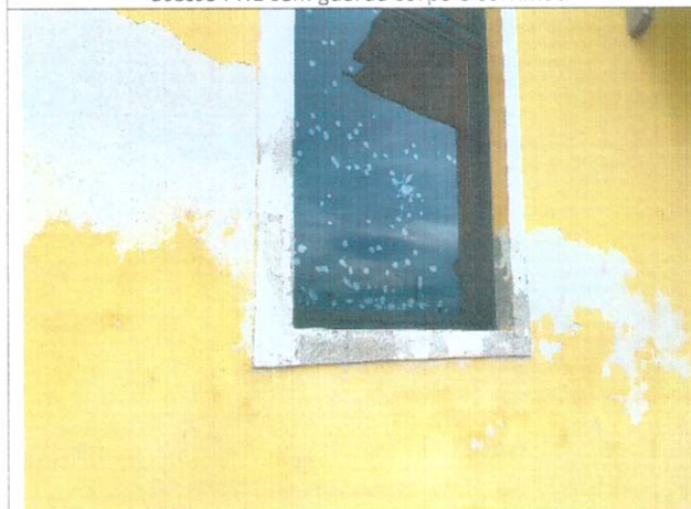
FIGURA 64 janela lado direito frontal da área de acesso – descascamento de tinta
