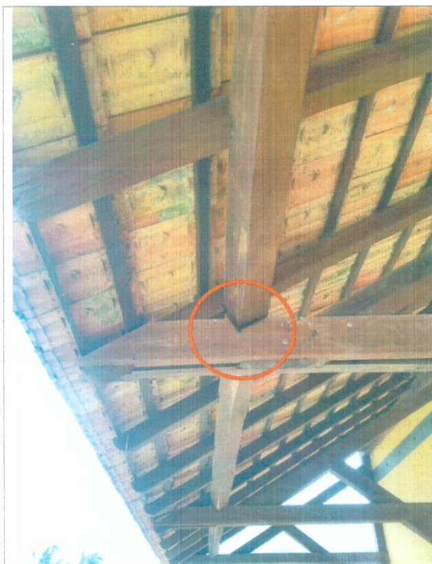
Figura 03: Treliça em madeira na cobertura do embarque/desembarque – peça de madeira(terça) fora do apoio
