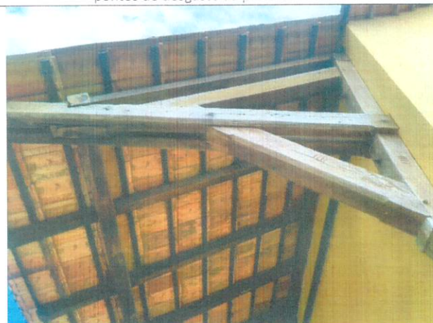
Figura 13: vista da fachada de acesso a estação – madeiras sem pintura de proteção
