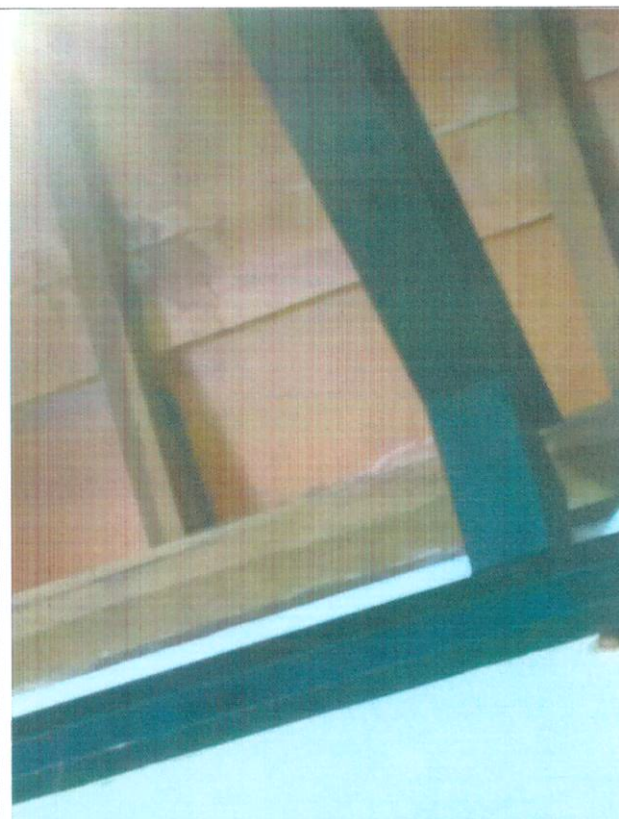
Figura 34: marcas de umidade no forro em MDF
