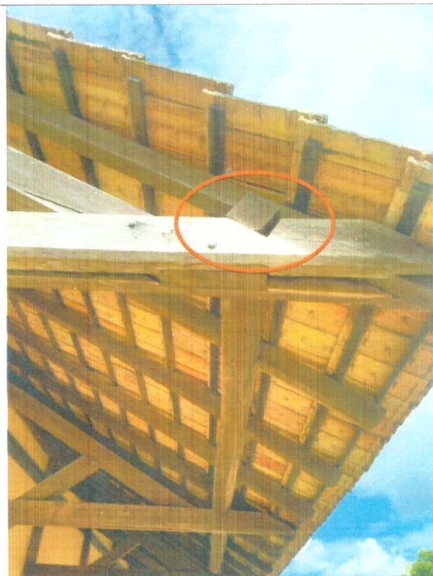
Figura 06: Trelça em madeira na cobertura do embarque/desembarque – peça de madeira(terça) fora do apoio na borda do telhado
