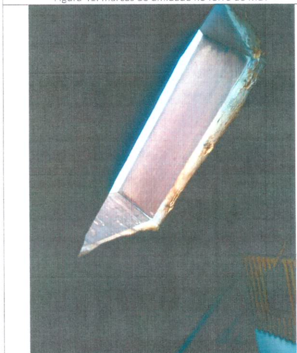
Figura 43: danos no forro em MDF na borda da clarabóia
