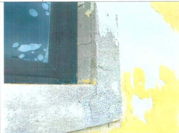
FIGURA 65 janela lado direito frontal da área de acesso – detalhe da fragmentação do reboco da moldura da janela
