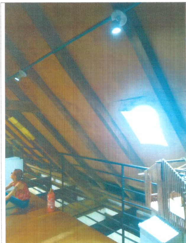
Figura 41: marcas de umidade no forro de MDF
