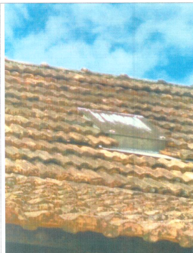
Figura 33: claraboia executada em madeira, com vidro com acumulo de detritos, sem vigia (abertura) – função de iluminação reduzida
