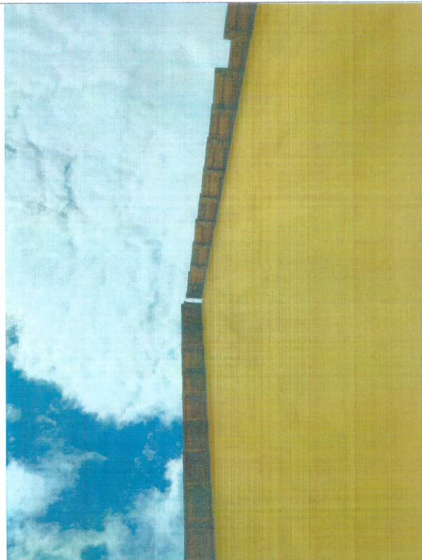
Figura 12: Vista do oitão da fachada - faltam telhas e acabamento na cumeeira – ponto de ingresso de água
