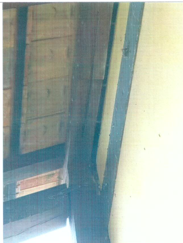
FIGURA 57 Vigas de ligação da cobertura da área de embarque estão afastadas da parede
