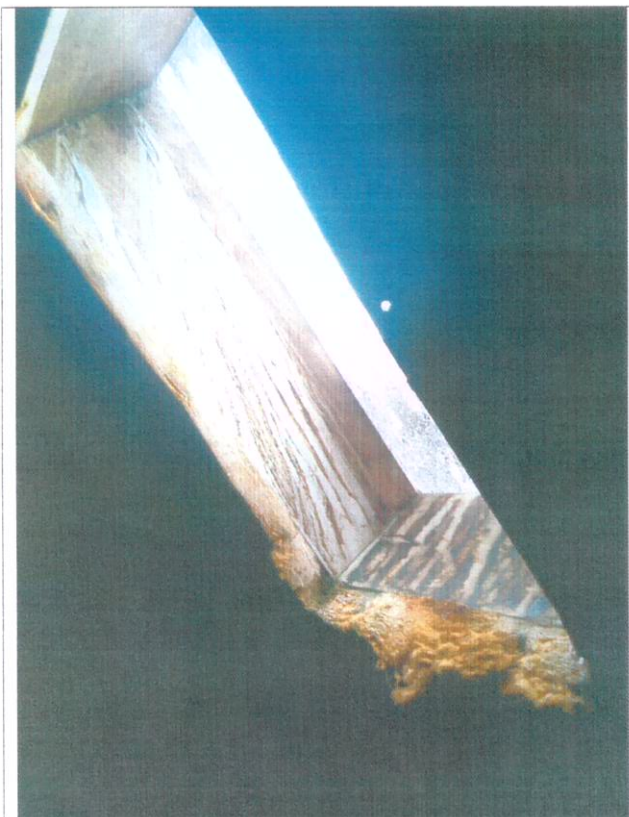
Figura 37: danos no forro em MDF na borda da clarabóia
