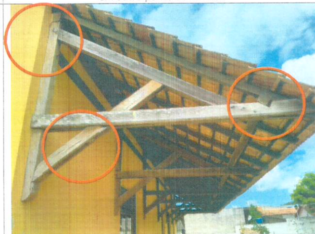
Figura 10: Treliça em madeira na cobertura do embarque/desembarque – peça de madeira (terça) fora do apoio na borda do telhado – vista geral – peças em pintura de proteção – madeira de suporte rachada – fissura na parede indicando que houve deslocamento da peça de apoio – risco eminente presumido
