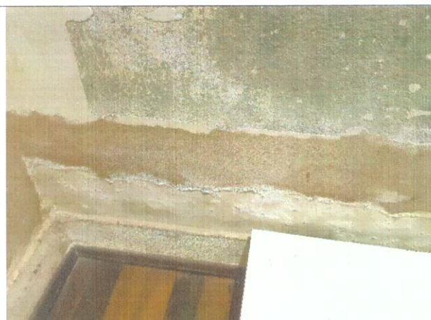
FIGURA 68 sinais de umidade ascendente nas áreas onde foi feito recorte para passagem de tubulação elétrica
