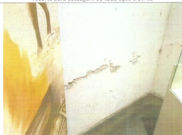
FIGURA 70 descascamento de tinta na parede oposta interna da figura 58
