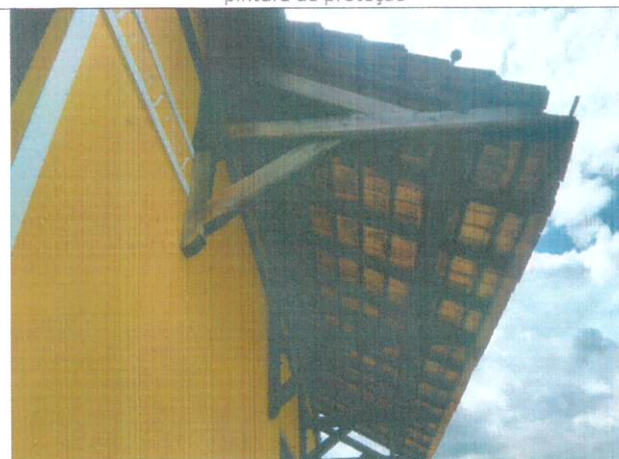
Figura 17: vista da fachada de acesso a estação – madeiras sem pintura de proteção e faltando uma telha
