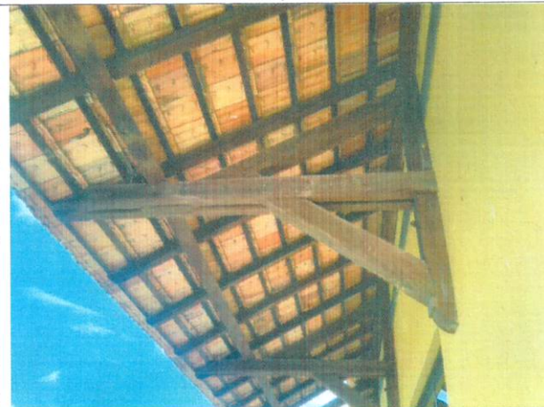
Figura 14: vista da fachada de acesso a estação – madeiras sem pintura de proteção
