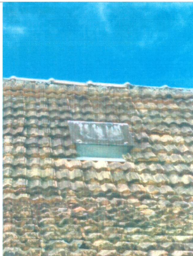
Figura 32: claraboia executada em madeira, com vidro com acumulo de detritos, sem vigia (abertura) – função de iluminação reduzida
