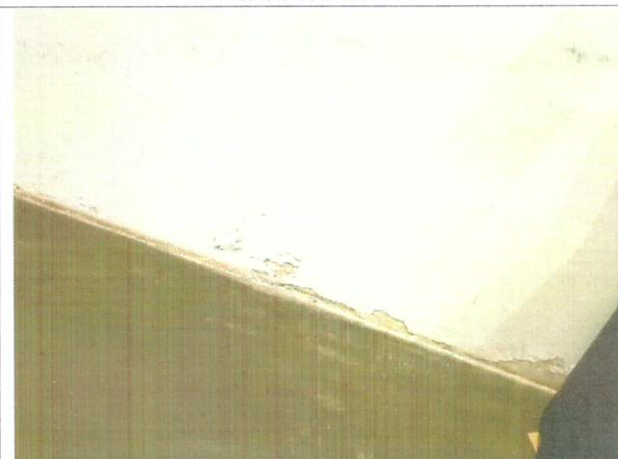
FIGURA 69 umidade ascendente na área interna do museu
