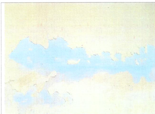
FIGURA 66 descascamento de tinta na parede frontal lado direito
