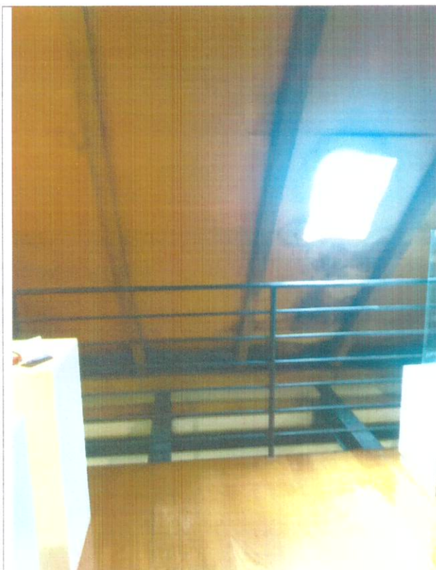
Figura 49: vista dos danos do forro do MDF próximo a claraboia
