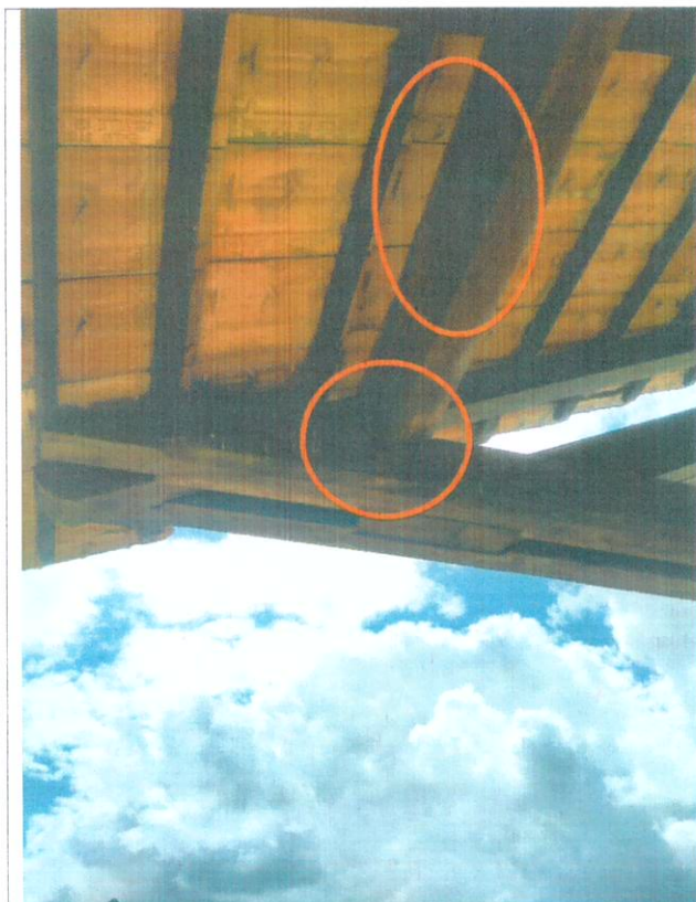
Figura 07: Treliça em madeira na cobertura do embarque/desembarque – peça de madeira (terça) fora do apoio na borda do telhado – vista por outro ângulo – terça rachada
