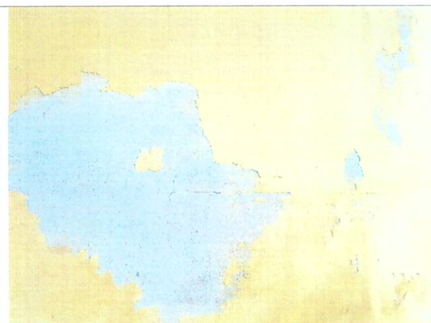
FIGURA 67 descascamento de tinta na parede frontal lado direito – sinais de umidade
