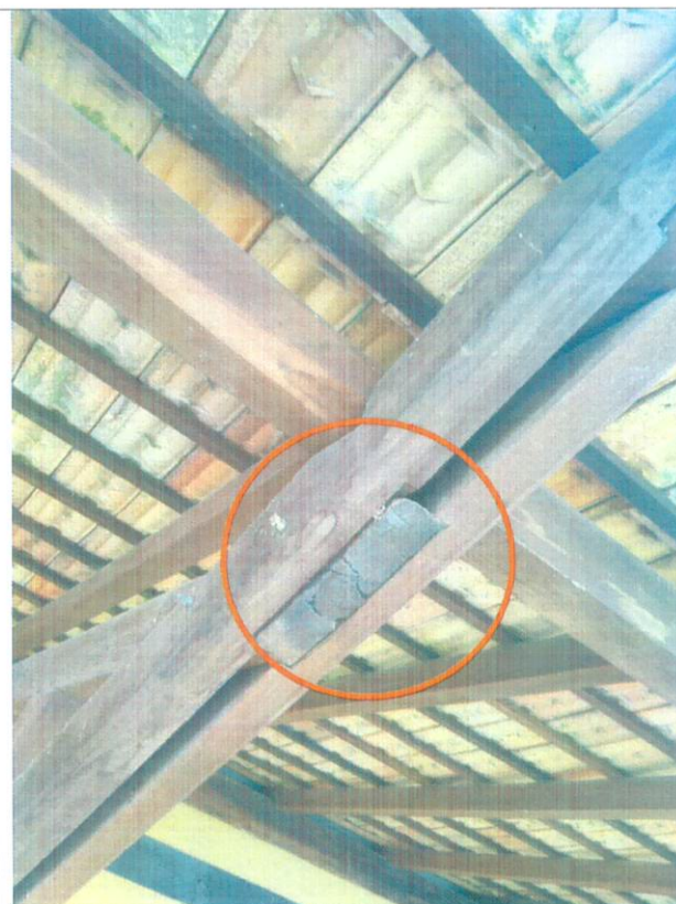
Figura 04: Treliça em madeira na cobertura do embarque/desembarque – peça de madeira(terça) fora do apoio – vista inferior
