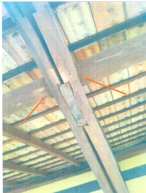
Figura 02: Treliça em madeira na cobertura do embarque/desembarque – peça de madeira com encaixes desencontrados/ emendas das terças feitos com ângulo de 90° e fora do apoio
