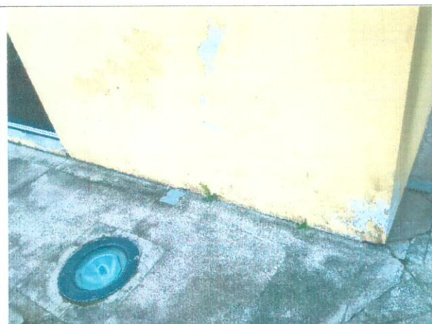
FIGURA 81 calçadas com deslocamento de concreto próxima a parede lado esquerdo da área de embarque
