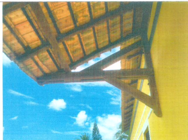
Figura 16: vista da fachada de acesso a estação – madeiras sem pintura de proteção
