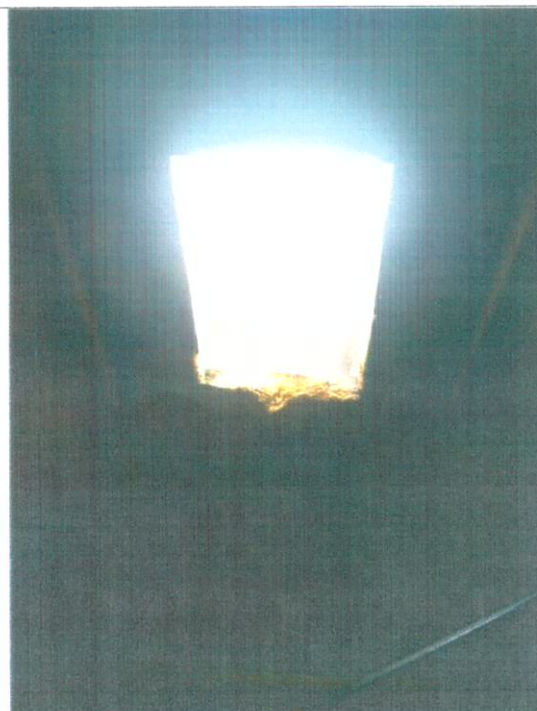
Figura 36: danos no forro em MDF na borda da clarabóia
