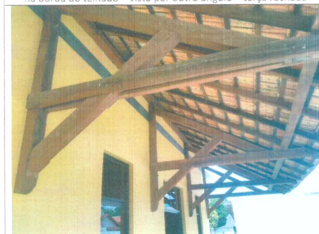
Figura 09: Treliça em madeira na cobertura do embarque/desembarque – estrutura afastou-se levemente da parede – peças sem pintura de proteção
