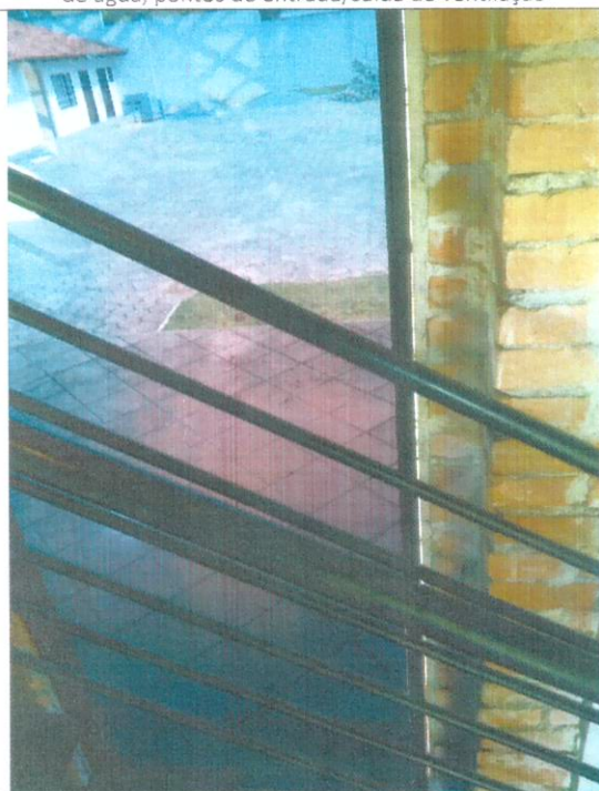
Figura 55: falta de vedação das esquadrias – pontos de ingresso de água, pontos de entrada/saída de ventilação
