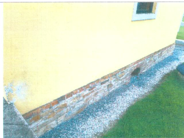
FIGURA 61 Descascamento de tinta na parede lado direito da área de embarque
