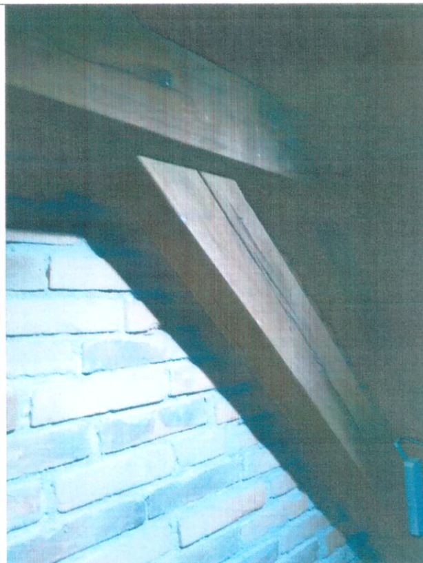
Figura 38: madeira da treliça interna rachada
