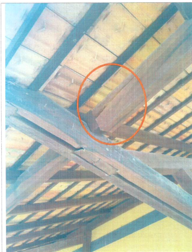
Figura 01: Treliça em madeira na cobertura do embarque/desembarque – peça de madeira rachada e encaixes desencontrados/emenda da terça com ângulo 90° e fora do apoio
