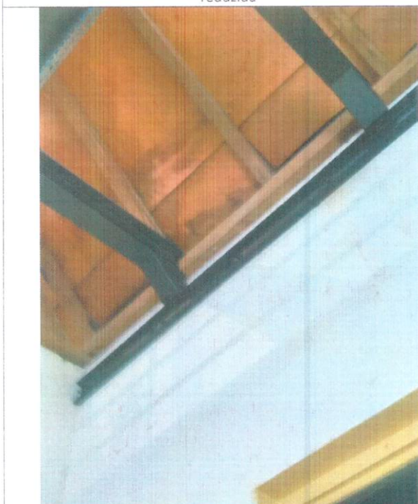
Figura 35: marcas de umidade no forro em MDF
