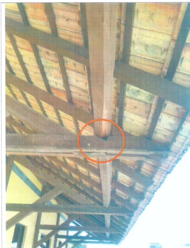
Figura 05: Trelça em madeira na cobertura do embarque/desembarque – peça de madeira(terça) fora do apoio – vista lateral
