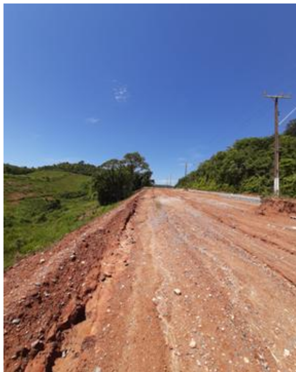
Talude da nova via obriga um maior afastamento dos postes para conseguir sustentação
