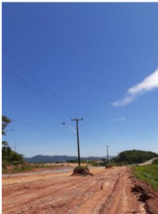
Rede de distribuição existente ficou dentro do traçado da rua Manoel Bernardes duplicada
