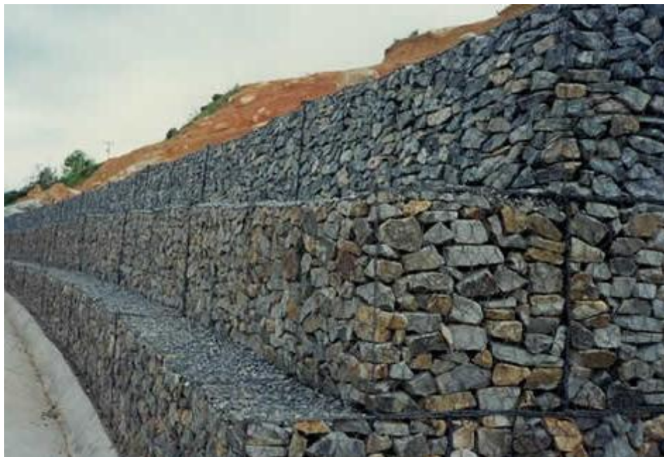
Figura 02 Gabião caixa Montado
