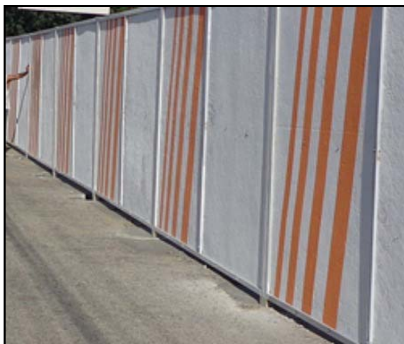
Figura 02 – Tapume de Compensado h=2,00m
