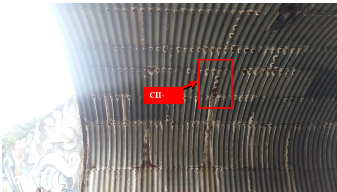
Figura 23 - Região de Aplicação da placa ou tratamento - CH-11E
