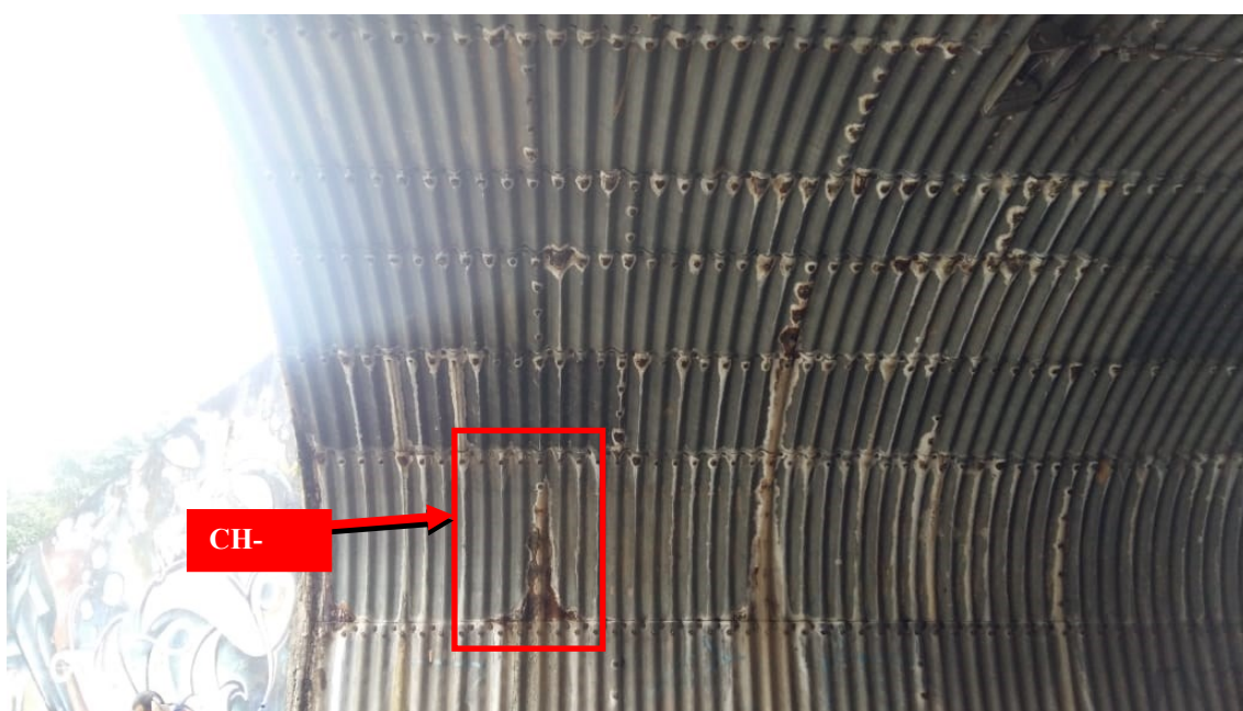
Figura 21 - Região de Aplicação da placa ou tratamento - CH-09E
