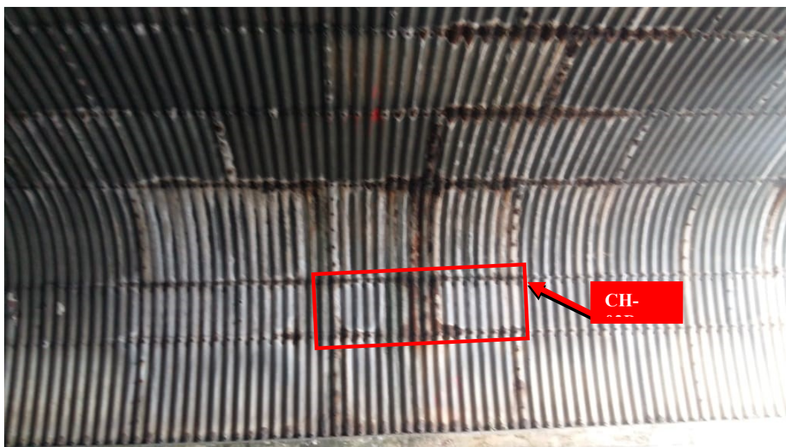
Figura 5 - Região de Aplicação da placa ou tratamento - CH-02D
