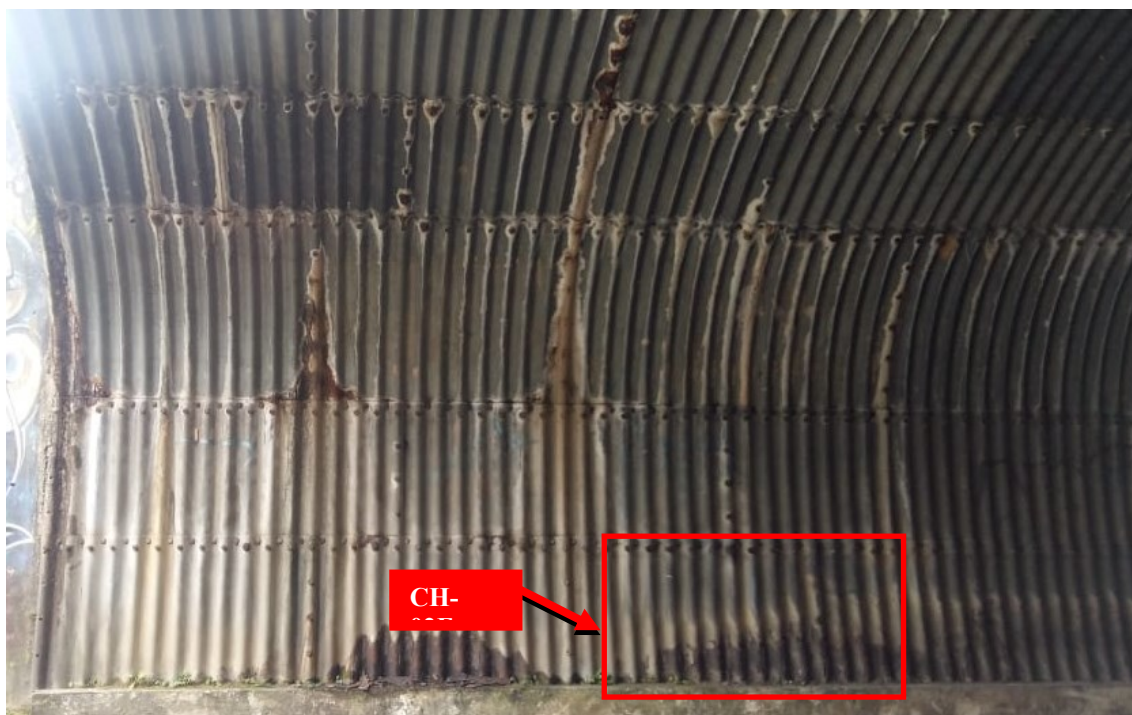
Figura 14 - Região de Aplicação da placa ou tratamento - CH-02E
