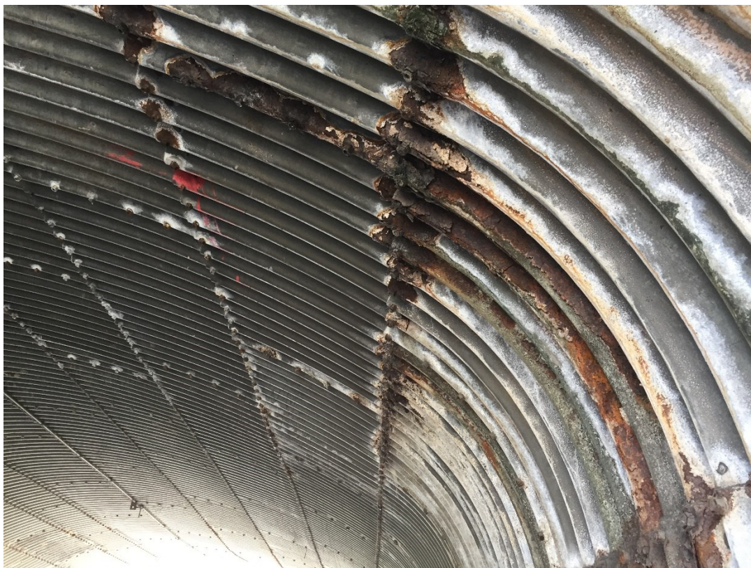
Figura 26 - Áreas de tratamento com laminação das placas
