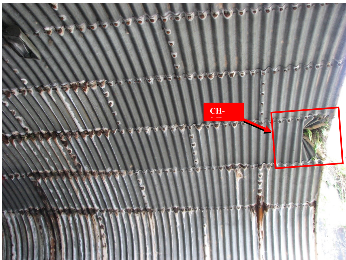
Figura 9 - Região de Aplicação da placa ou tratamento - CH-06D
