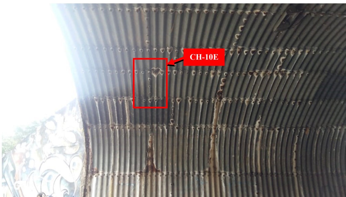
Figura 22 - Região de Aplicação da placa ou tratamento - CH-10E
