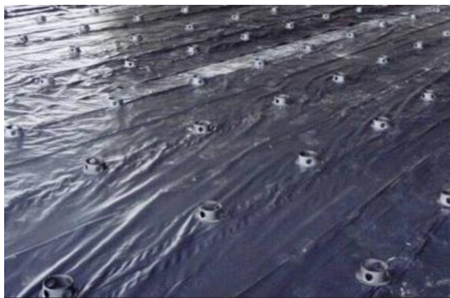
Figura 4: Impermeabilização com lona preta e espaçadores de concreto
