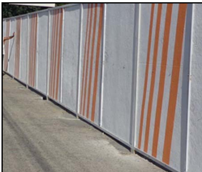
Figura 02 – Tapume de Compensado h=2,00m
